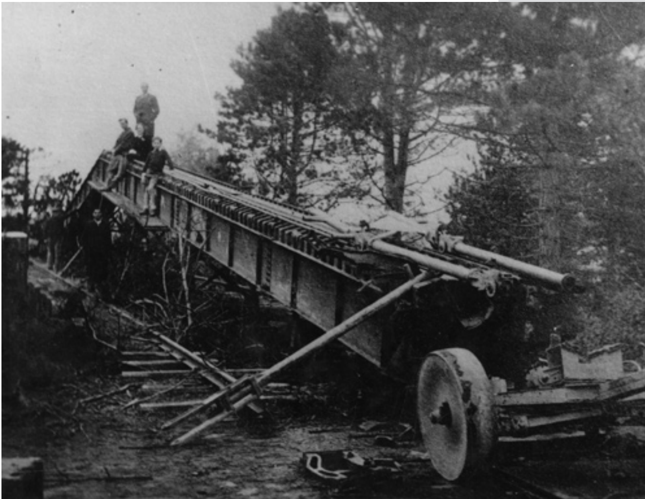
Une base de lancement de V1 est constituée d'une longue piste bétonnée, d'une catapulte, d'une rampe de lancement de 50 m de long, de bâtiments pour le montage des bombes et de réservoirs de combustible.
